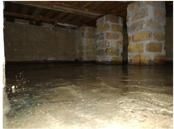
#4 Terrændæk i krybekælder kan tilsvarende behandles.
