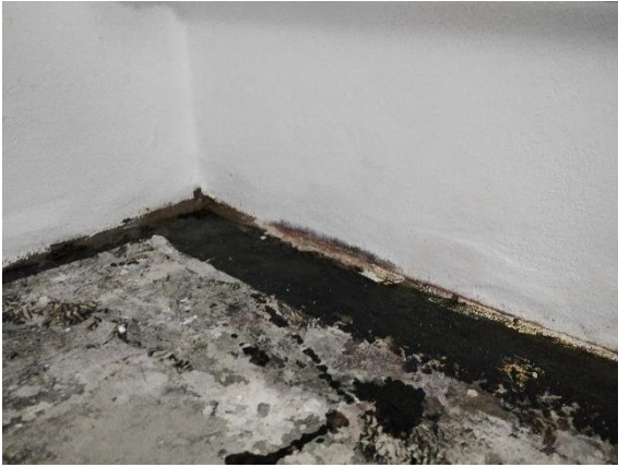
#1 Gulv rengøres og slibes om nødvendigt, før kanter forsegles med pensel.
