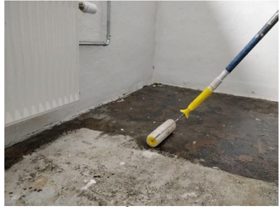
#2 Gulvfladerne påføres SPS Radon block med rulle.
